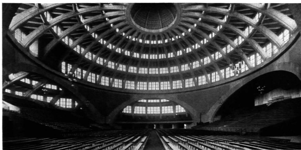
129. Max Berg: Jahrhunderthalle in Breslau. 1910/12. Kuppelraum
