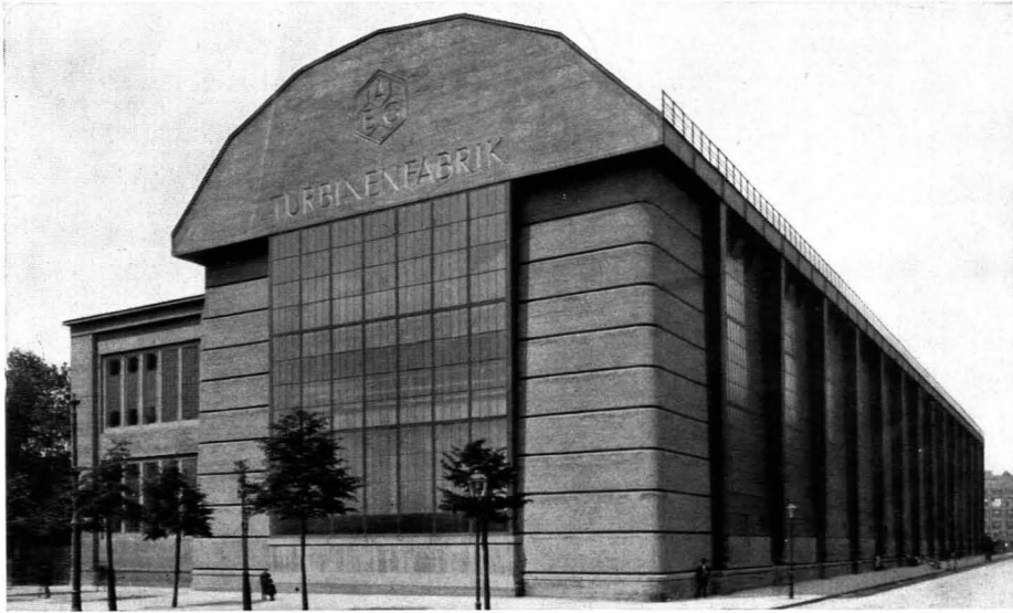
116. Peter Behrens: Turbinenhaus der AEG. in Berlin. 1909
