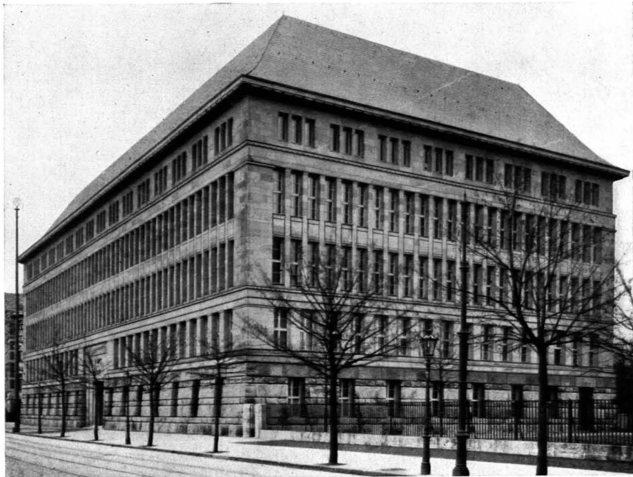
117. Peter Behrens: Verwaltungsgebäude der Mannesmannwerke in Düsseldorf. 1912
