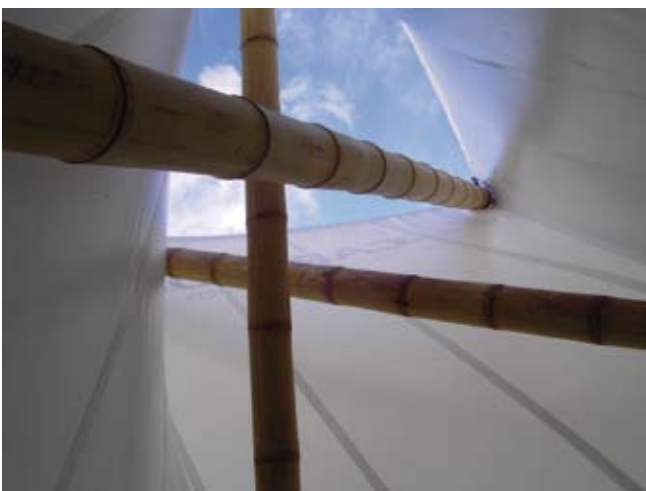
Studentischer Experimentalbau TRINEX: Bambus und Membran
