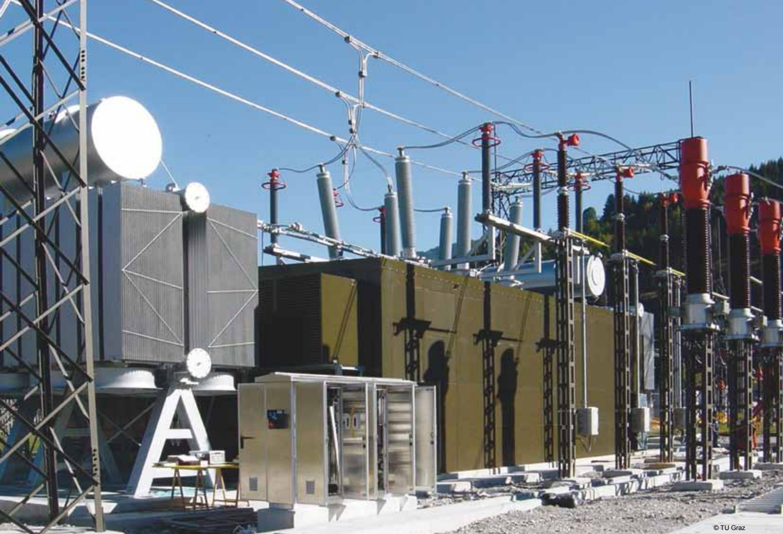
Abb. 1: Phasenschiebertransformator im österreichischen Verbundnetz.
