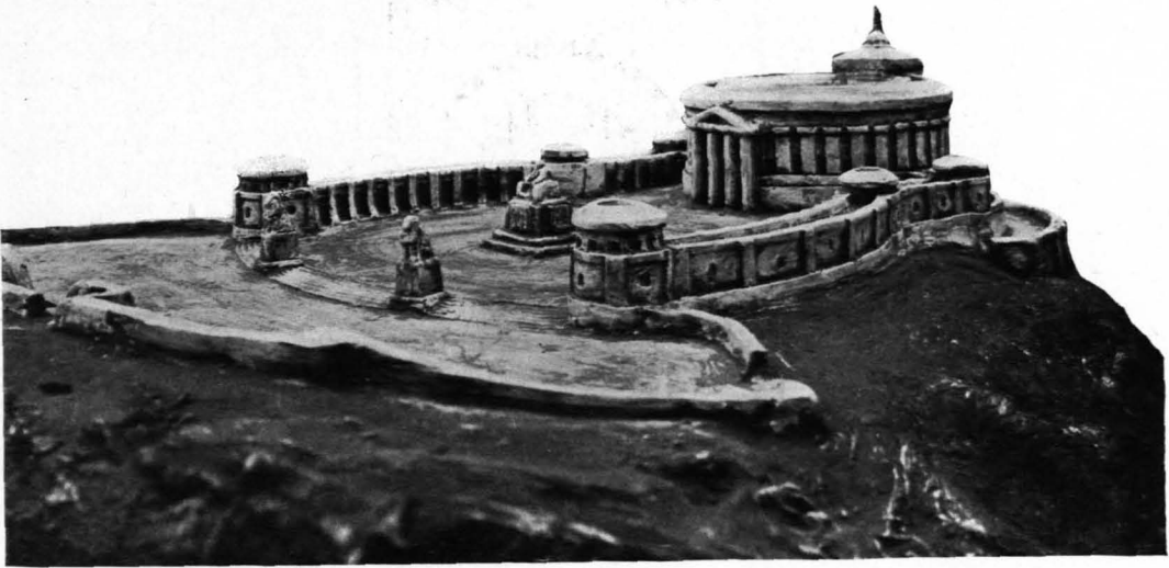
Abb. 189. BLICK IN DEN HOF.
