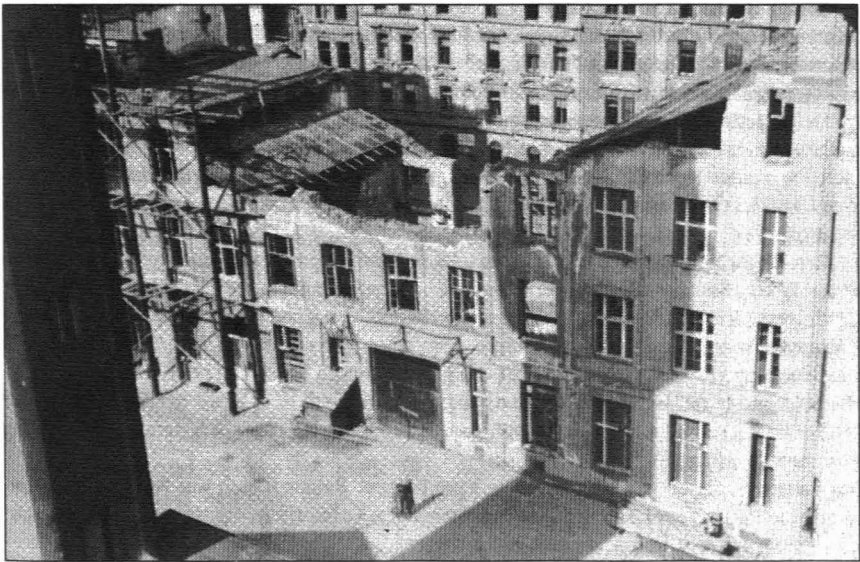
Abb. 42: Die »Neue Technik« war 1945 durch mehrere Bombentreffer zerstört und einsturzgefährdet.
