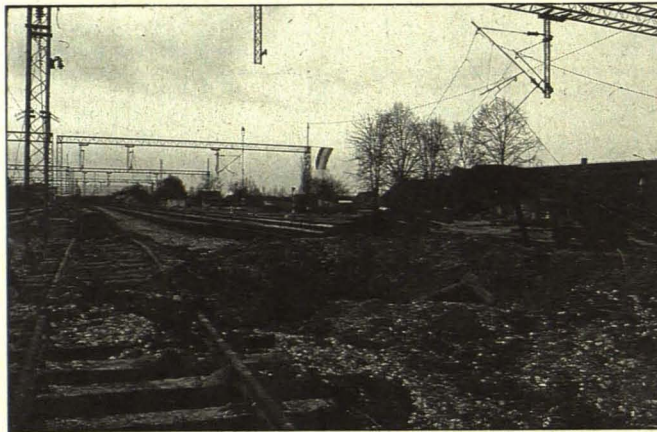
Beschädigter Bahnhof in Novska
