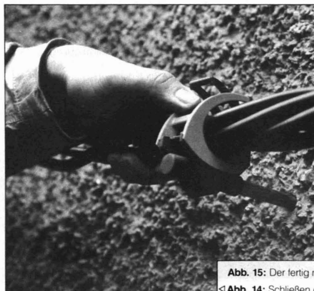
◁ Abb. 14: Schließen der Kabelhalterung.
