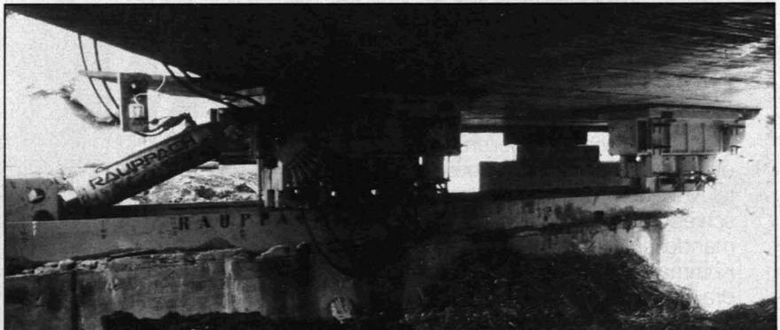
**Abb. 9:** Durch den Einsatz neu entwickelter Spezialhubzylinder erfolgt die Höhenkorrektur des Bauwerkes während des Verschiebevorganges.
