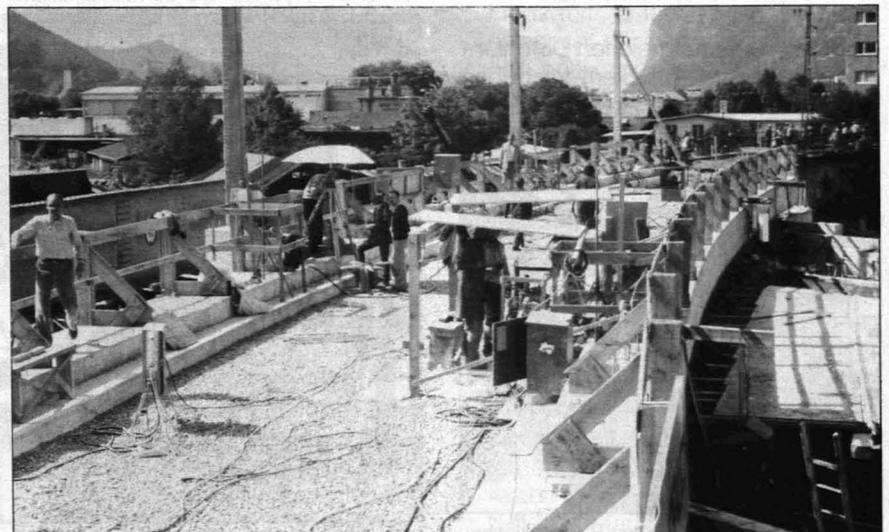
**Abb. 4:** Die Präzisionshöhenvermessung (Meßinstrument unter Sonnenschirm) erfolgt am Brückentragwerk in den Verschiebepausen.
