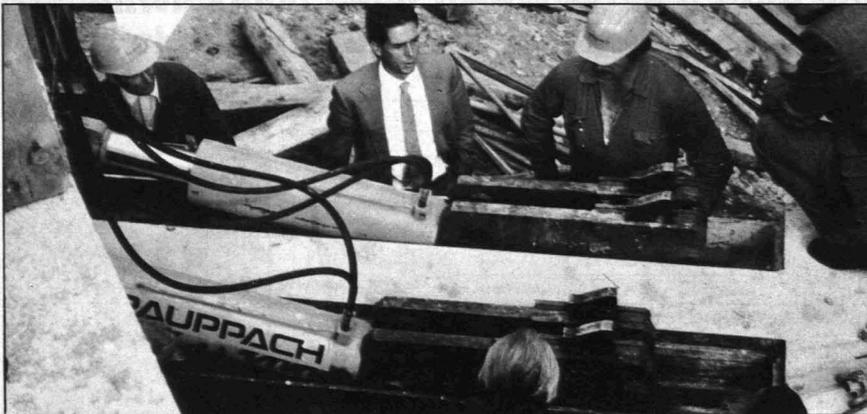
**Abb. 6:** Anordnung der Verschiebzyylinder und Hydraulikböcke in der Verschiebbahn Nr. 2.
