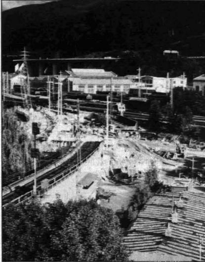
**Abb. 2:** Bild der Baustelle vor Beginn des Tragwerkeinschubes von links nach rechts. Das alte Stahltragwerk befindet sich bereits im ausgeschobenen Zustand rechts im Bild.
