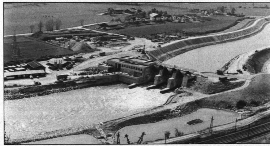
Abb. 5: Baustelle KW Urreiting, 23 Monate nach Baubeginn
