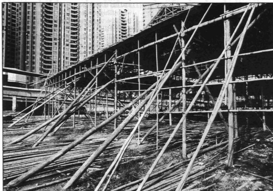
Abb. 2: Bambus — das Baugerüst der Prosperität in Hong Kong
