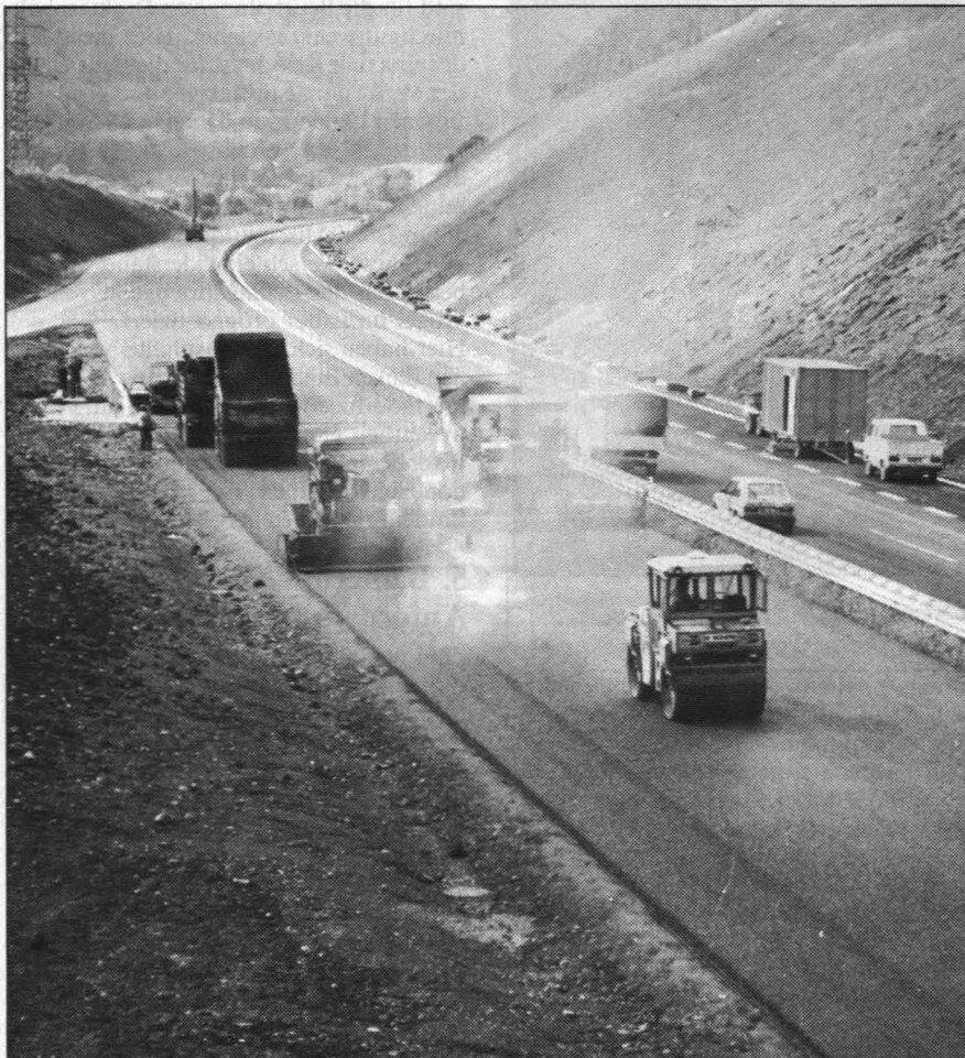
Abb. 5: Verlegung von Drainsphalt-Mischgut auf bereits vorher aufgebracht SAMI-Schicht
