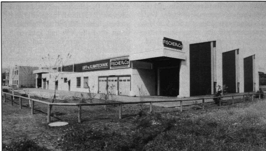
Neuer Firmensitz in der Straßanger Hafnerstraße.
