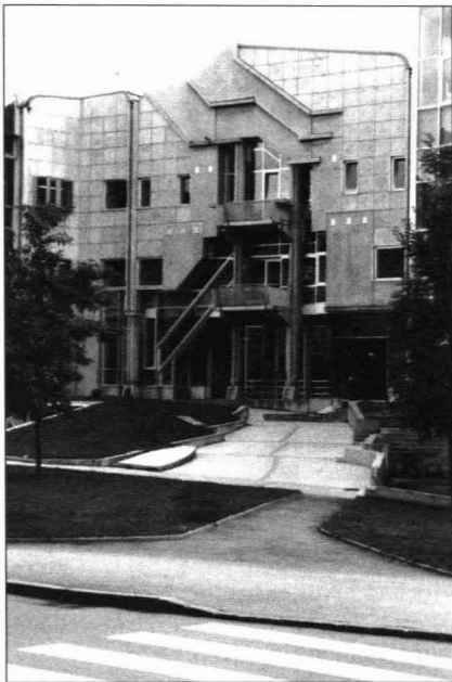
Abb. 3: Neubauten in der Petersgasse
