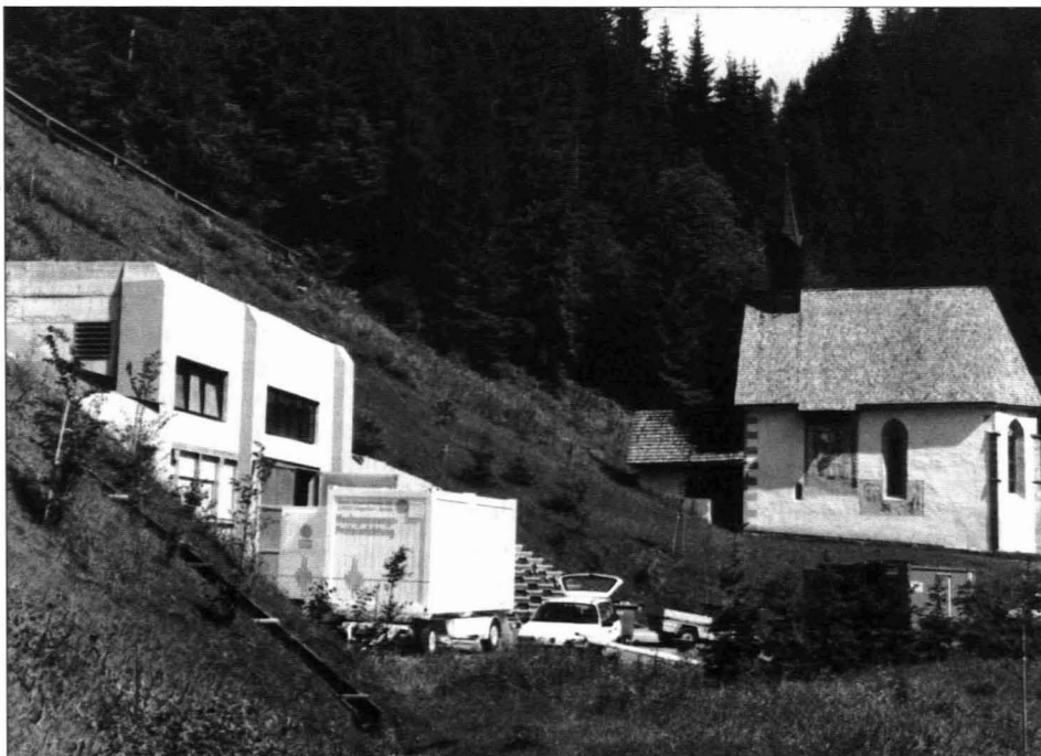
Das Kelag-Kraftwerk Radegund, neben der ältesten Kirche des Lesachtals, kurz vor seiner Fertigstellung
