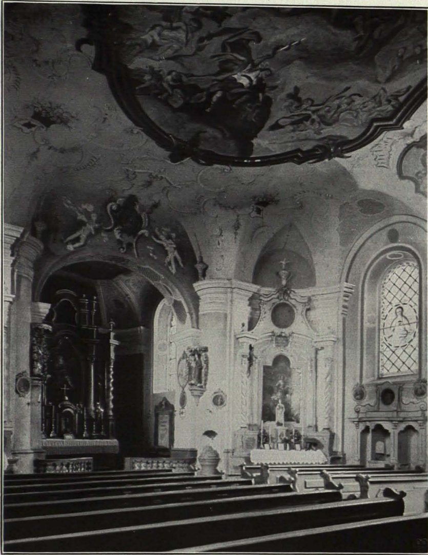
MOCKERSDORF (B.-A. KEMNATH). PFARRKIRCHE, 1746 VOLLENDET, VON JOHANN LÖSCH. STUCK UND MALEREI UM 1750
