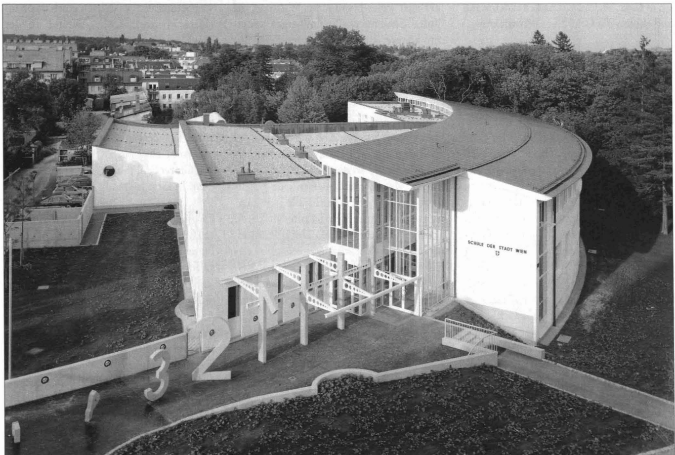
FOTO: RUPERT STEINER; SCHULE, ROHRWASSERGASSE, WIEN XII
