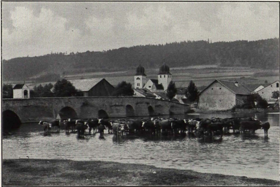
KOTTINGWÖRTH (B.-A. BEILNGRIES). TURM RECHTS FRÜHGOTISCH, DER ÜBRIGE BAU SPÄTER
