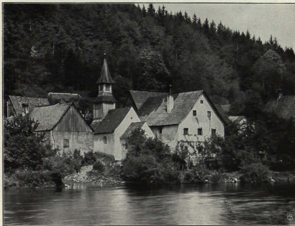
ETTERZHAUSEN (B.-A. STADTAMHOF). ROMANISCHE KAPELLE MIT SPÄTEREM TURM
