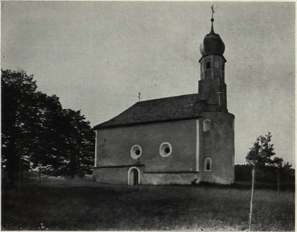
TIEFENTHAL (B.-A. REGENSBURG). ROMANISCHE KIRCHE, URSPRÜNGLICH ZWEIGESCHOSSIG. TURM BAROCK
