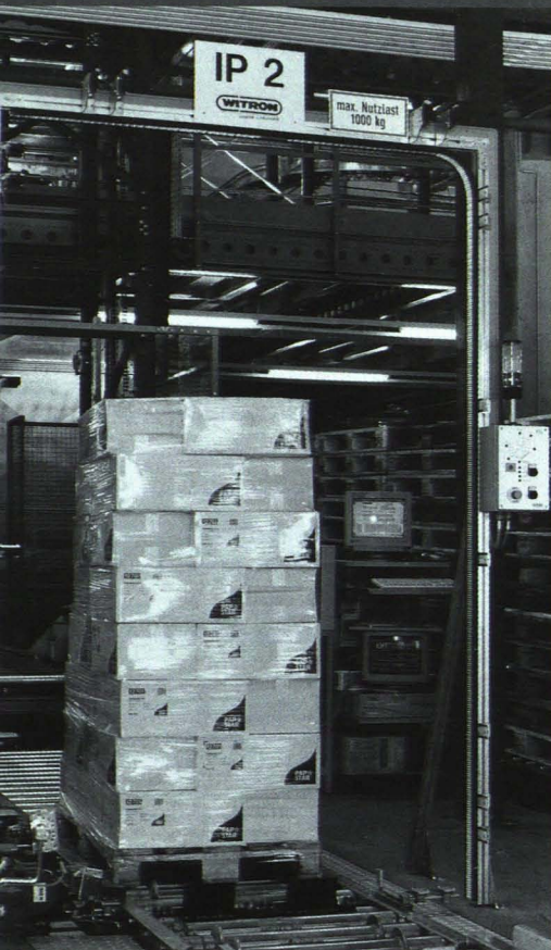
Spar Zentrallager Wels, Vollautomat, Warenübernahmestation zur Prüfung der Einlagerungstauglichkeit.
