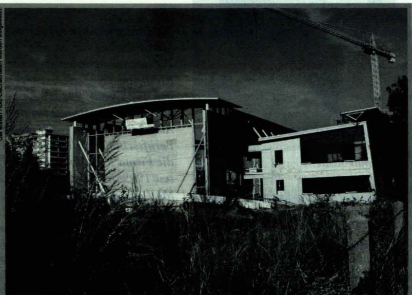
Bereichszentrum TU-Graz. Die ersten Holz-Dachstrukturen werden aufgesetzt.
