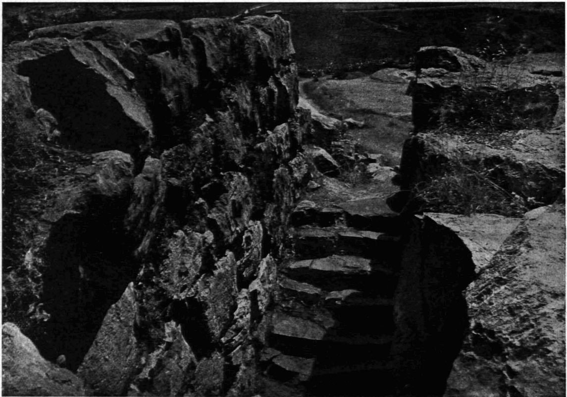
Abb. 60. Oberer Teil der Treppe zur Südgalerie, von Westen.
