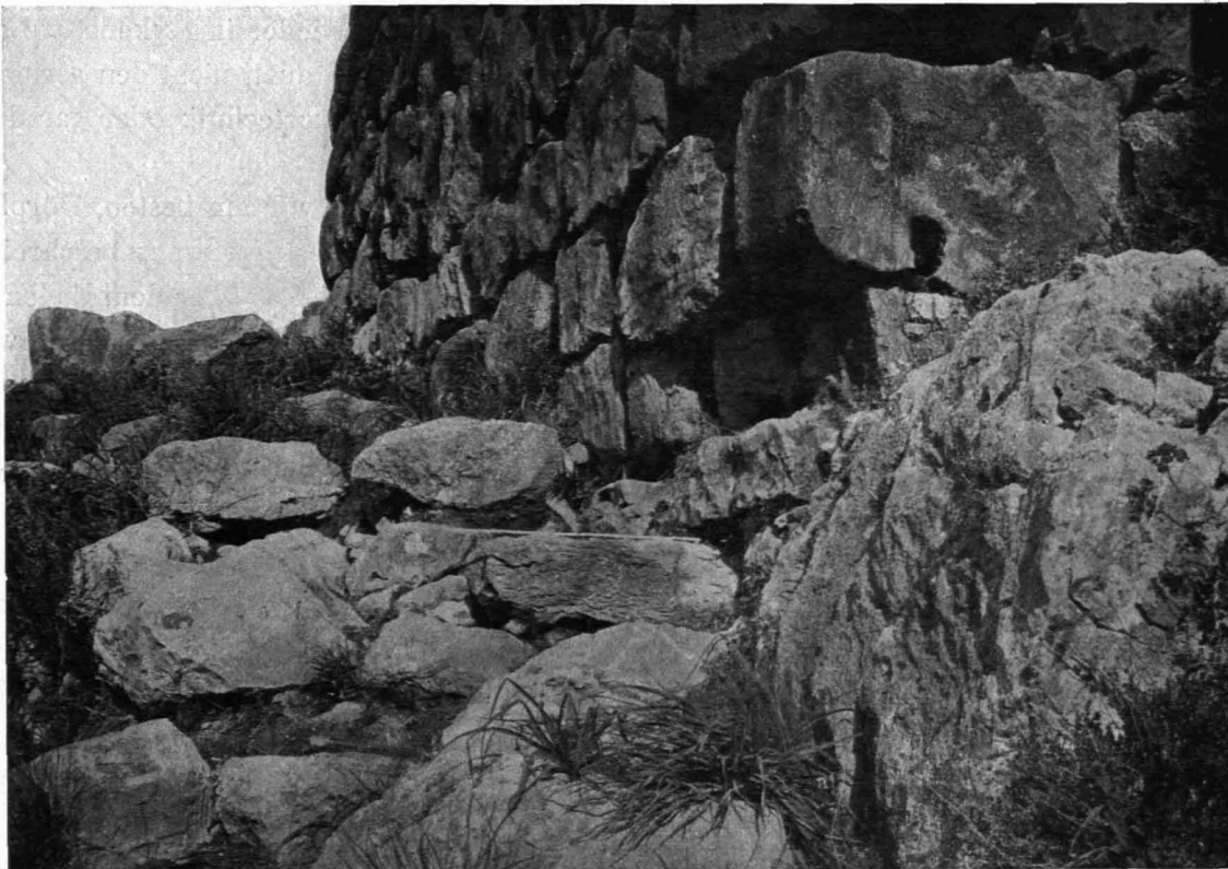
Abb. 26. Südlicher Anschluß der Bogenmauer der Westtreppe an die Oberburg, von Südwesten.
