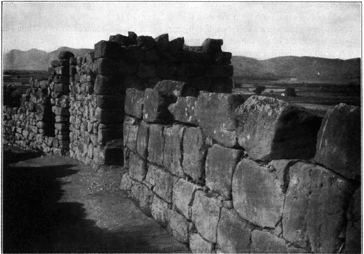
Abb. 22. Die Mauern östlich des äußeren Torwegs, von Südwesten.
