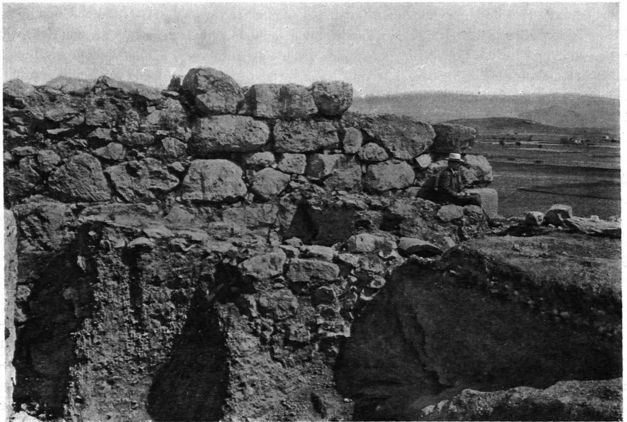
Abb. 15. Die Nordseite des äußeren Vorhofs.
