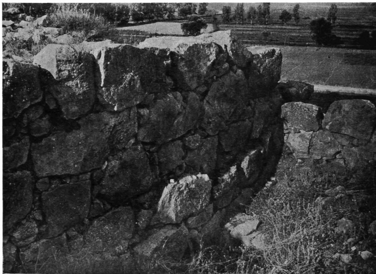
Abb. 8. Mauer der I. Burg, von jüngerer Mauer überbaut, an der Nordwestecke der Oberburg. Von Nordosten.
