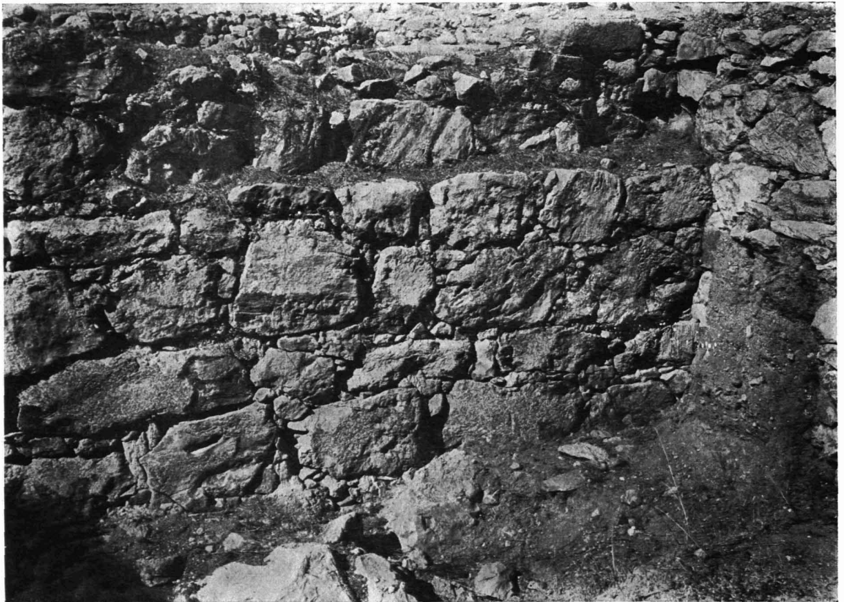
Abb. 3. Mauer der I. Burg nördlich des Tores.
