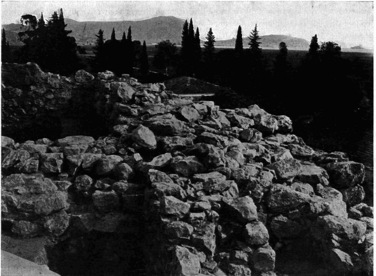
Abb. 58. Die Südwestecke der Burg von Norden. Links die Grube XLI, davor XLII; im Hintergrund Nauplia und die Insel Burzi.
