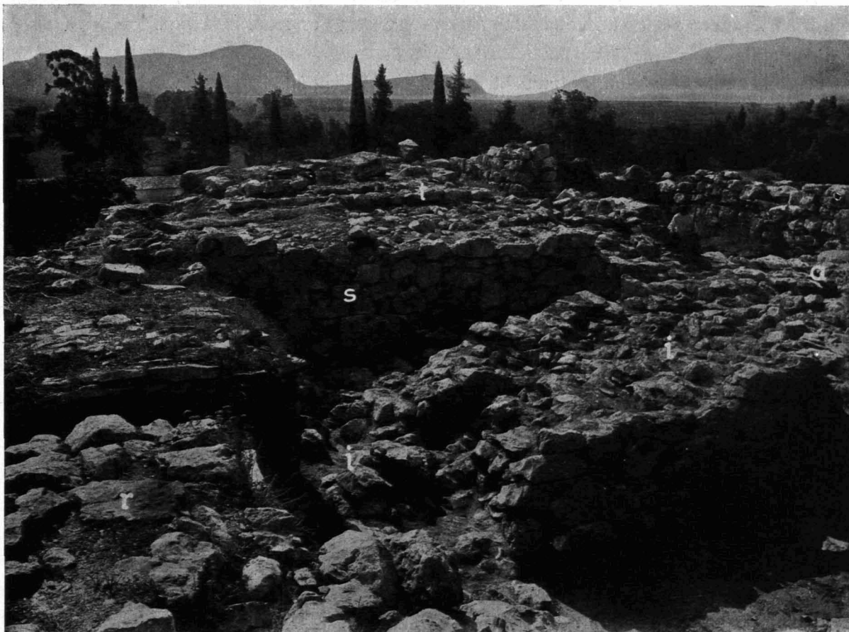
Abb. 61. Mauern in der Südburg, von Norden.
