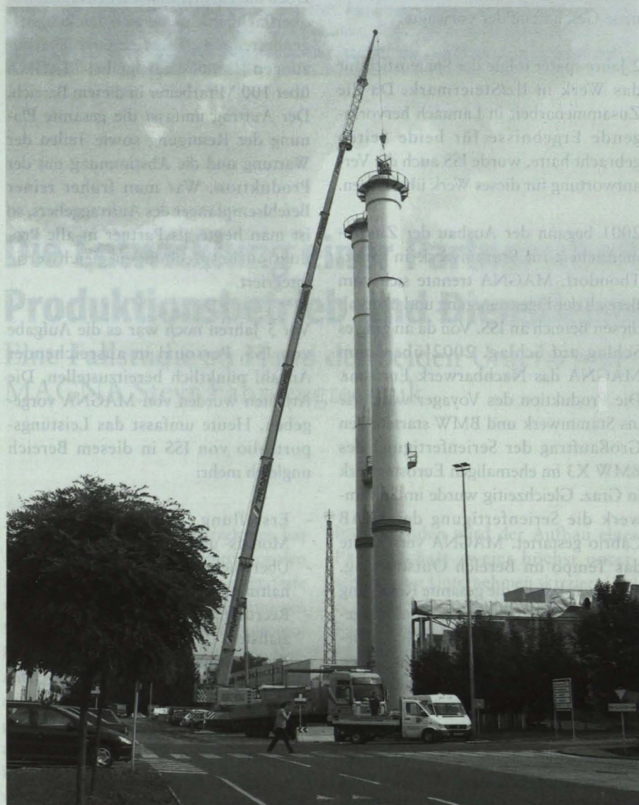
Abb. 2: Innenreinigung von Abluftkaminen
