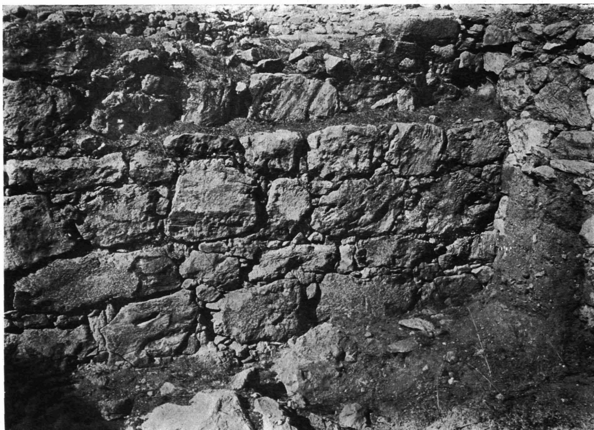
Abb. 3. Mauer der I. Burg nördlich des Tores.
