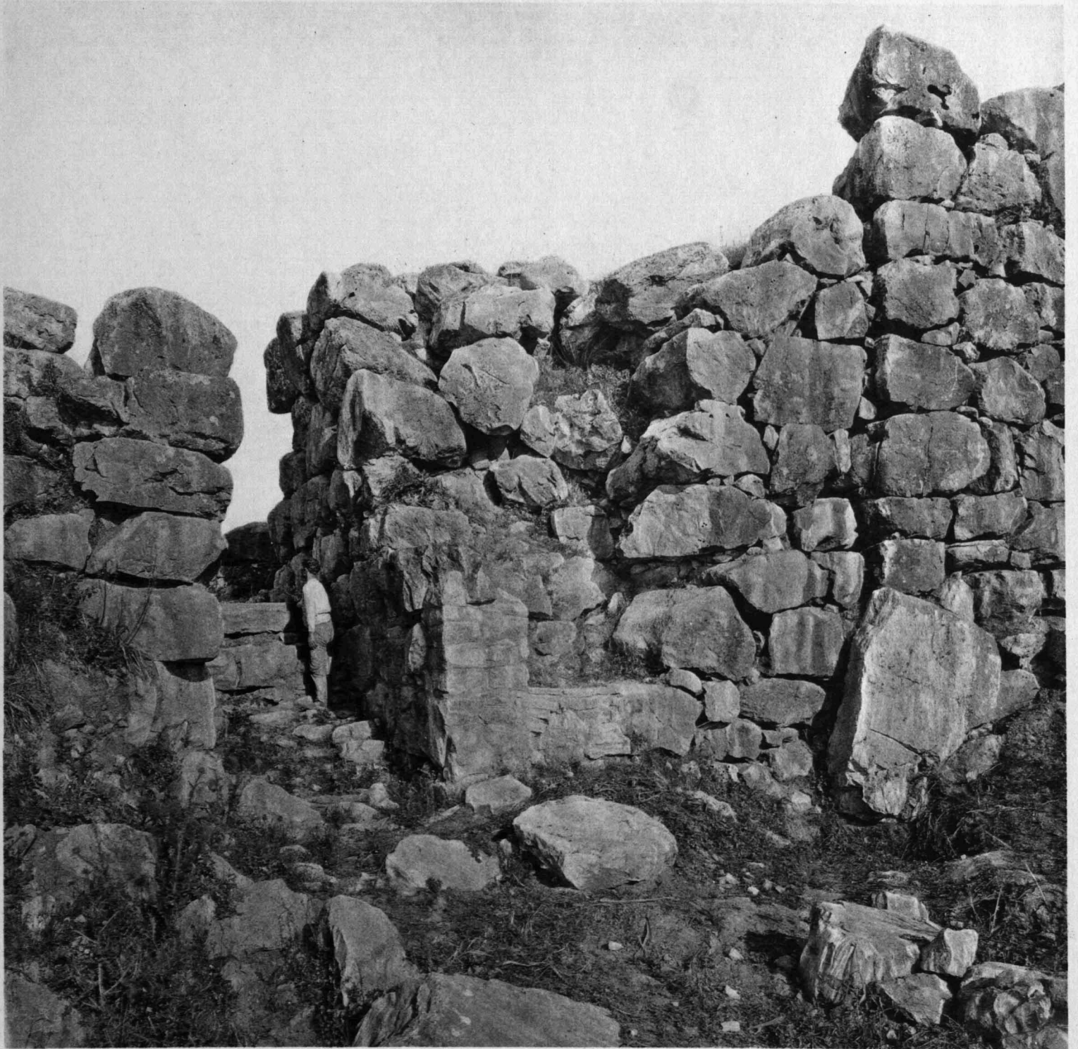
Westpforte der Unterburg von aussen
