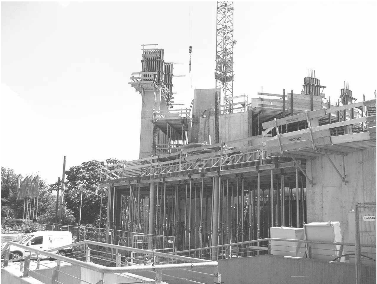
Abb. 3: Stahlbetonarbeiten – Wissensturm in Linz [Foto: Hofstadler]
