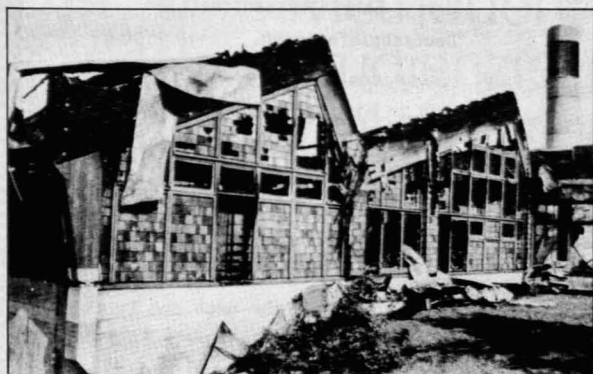
Für das Thermenobjekt wurde als Baustoff in erster Linie Holz verwendet. Die Außenwand war mit Schindeln verkleidet
