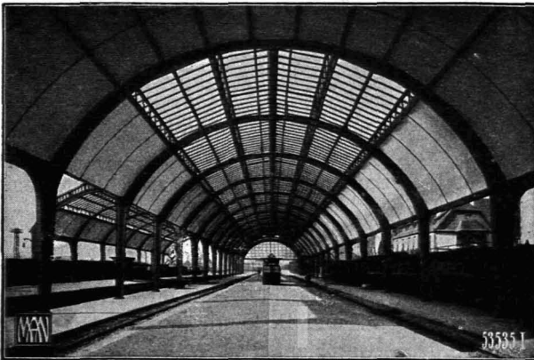
Abb. 166. Bahnhofshalle in Homburg v. d. H. (gebaut von der Maschinenfabrik Augsburg-Nürnberg). (TWL 5063.)
