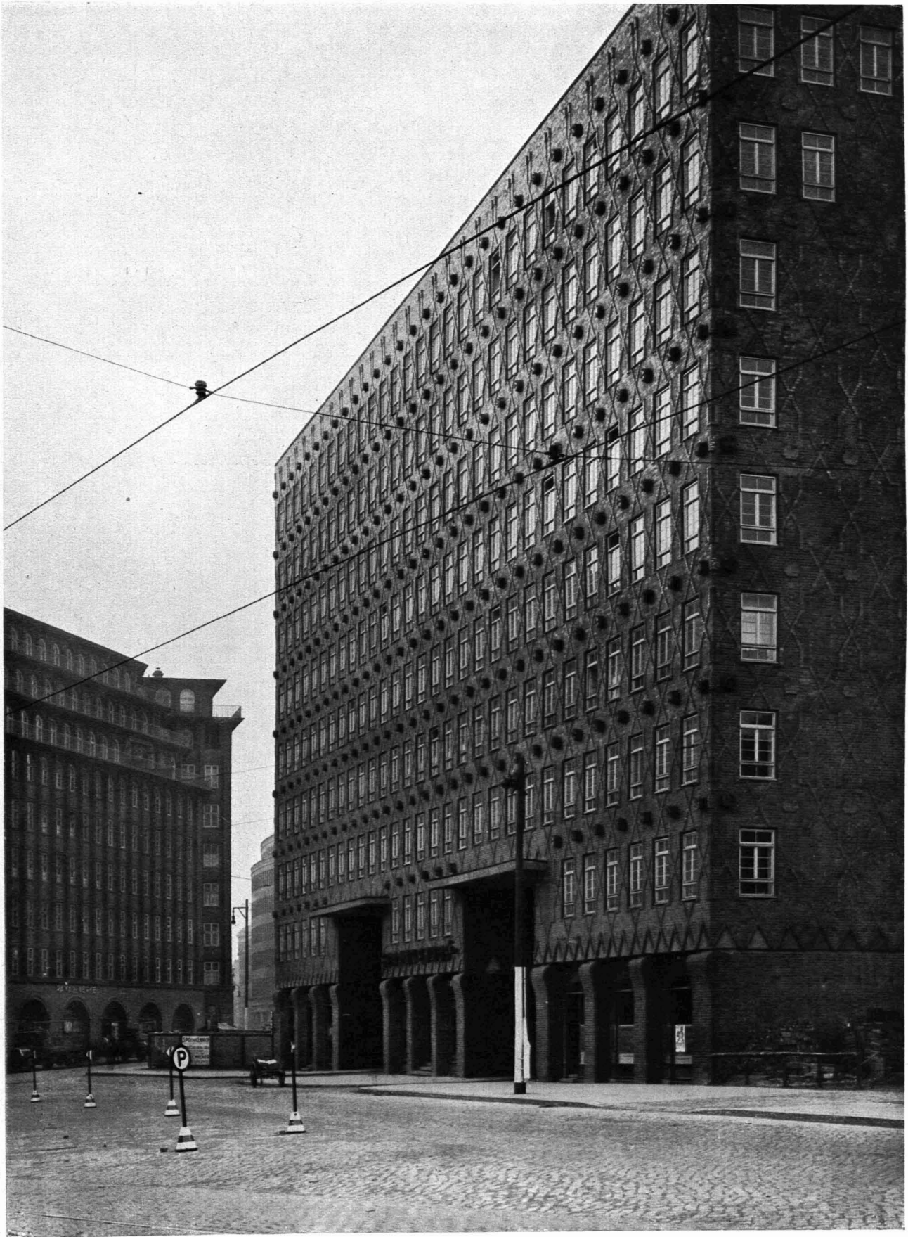
499 / HAMBURG Sprinkenhof Office Building Arch.: Fritz Höger, Hans und Oskar Gerson
