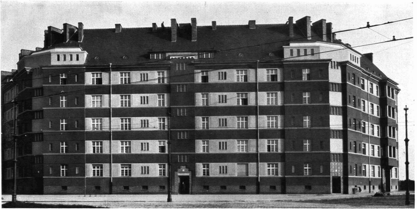
495 / BERLIN Dreibundstraße. Miethäuser Flats Arch.: Walter Borchardt
