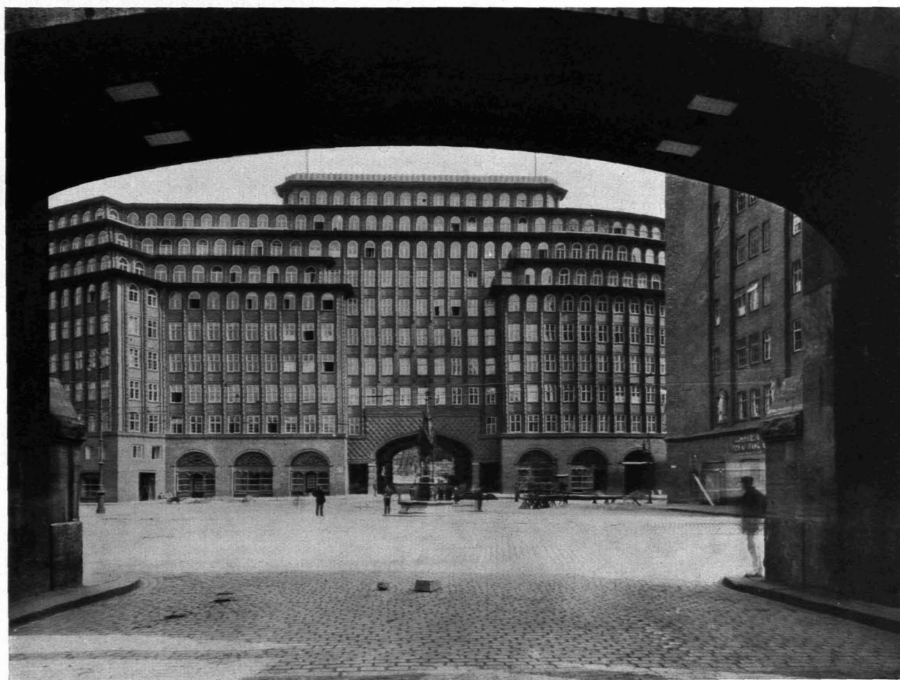
Chilehaus. (Vgl. Abb. 419—20) 487—88 / HAMBURG Chilehaus. Office Building. (Compare Ills. 419—20) Arch.: Fritz Höger
