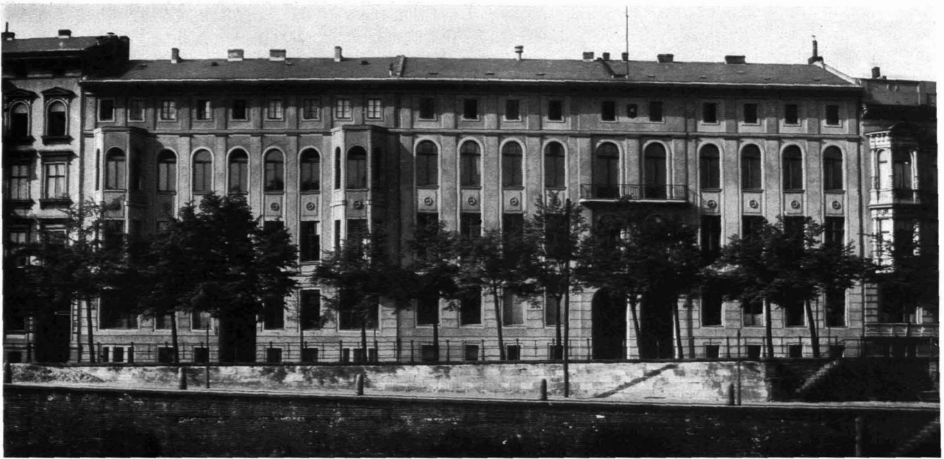
479 / BERLIN Kronprinzenufer 4-6. Drei alte Häuser zu einer neuen Einheit zusammengefaßt Three old houses made into one Arch.: Alexander Scharr
