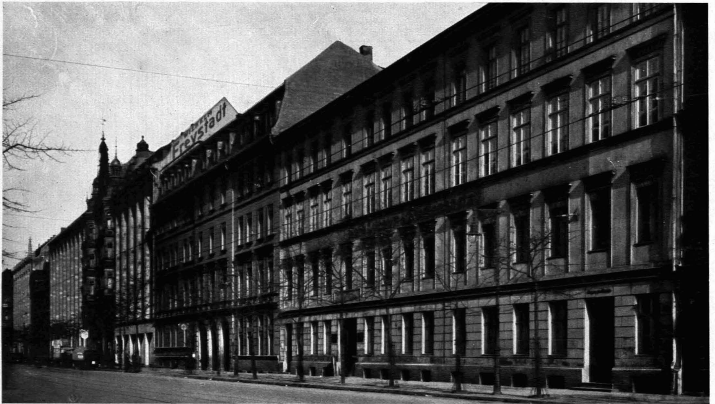
473 / BERLIN Lindenstraße. Alte und neue Häuser (vgl. Abb. 397—98) Old and new houses. (Compare Ills. 397—98)
