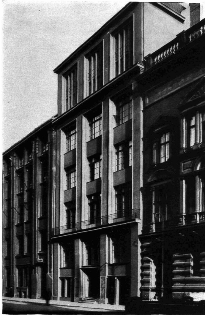
461 / BERLIN Taubenstr. 23. Umbau Transformation of old building Arch.: Paul Zucker
