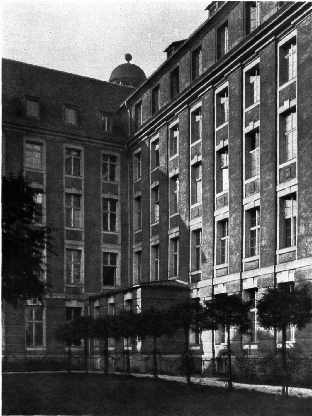
438 / BERLIN Friedrich-Karl-Ufer. Allgemeine Elektrizitäts-Gesellschaft Office Building Arch.: Alfred Messel
