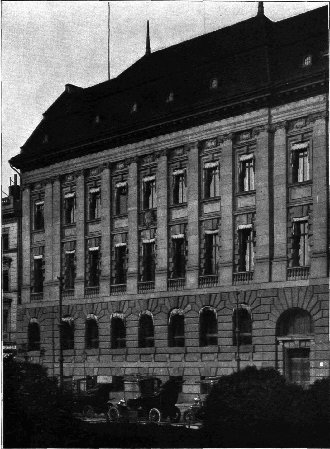
436 / BERLIN Berliner Handelsgesellschaft Bank Building Arch.: Alfred Messel
