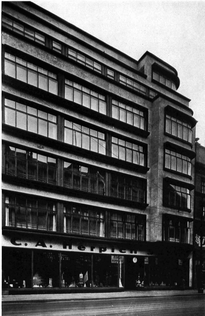
429 / BERLIN Umbau des Herpich-Hauses Department Store Arch.: Erich Mendelsohn, Berlin
