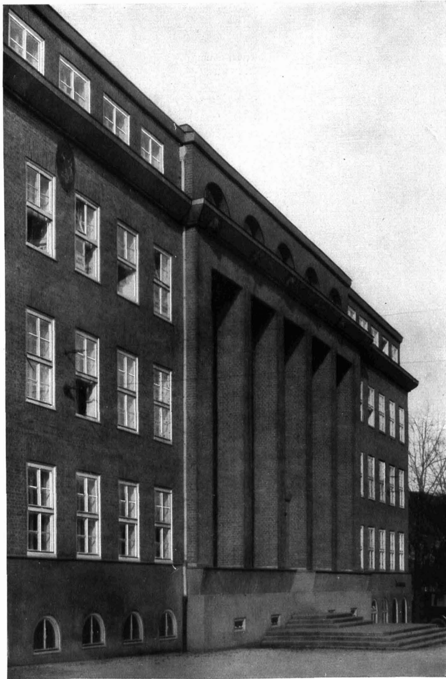
405 / ESSEN Bürohaus „Glückauf“ Office building Arch.: Ernst Bode
