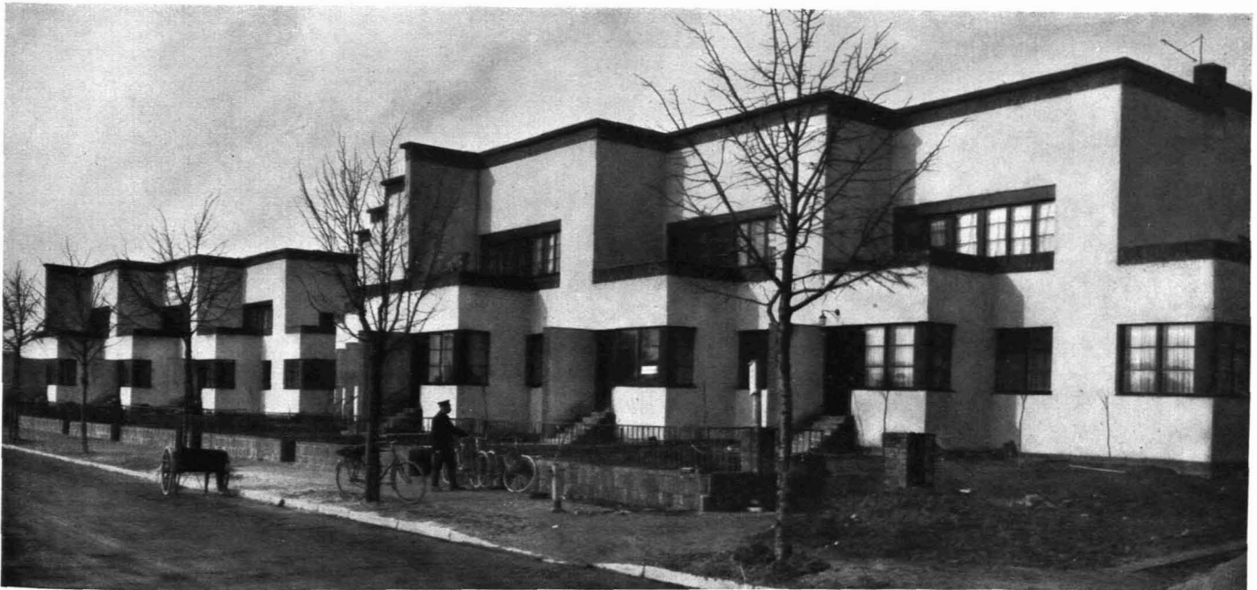
333 / BERLIN - DAHLEM Reihenhäuser. Das Brechen der Fassade schließt die einzelnen Häuser und Balkone besser gegen die Nachbarn ab, Flats. The broken façade gives privacy to the individual homes. Arch.: Brüder Luckhardt und Alfons Anker
