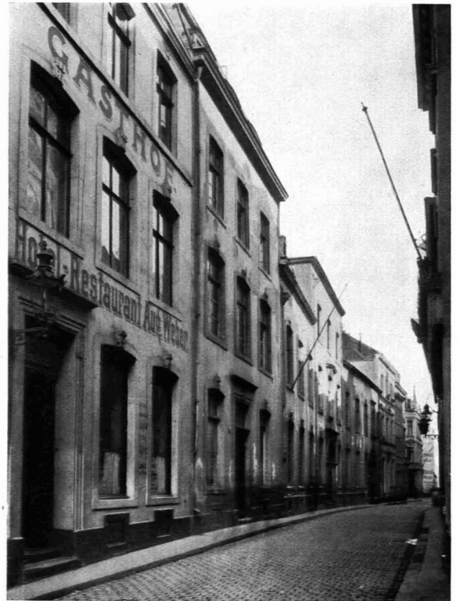
Johannisstraße 23—25. Etwa 1770. Teilweise abgebrochen About 1770
