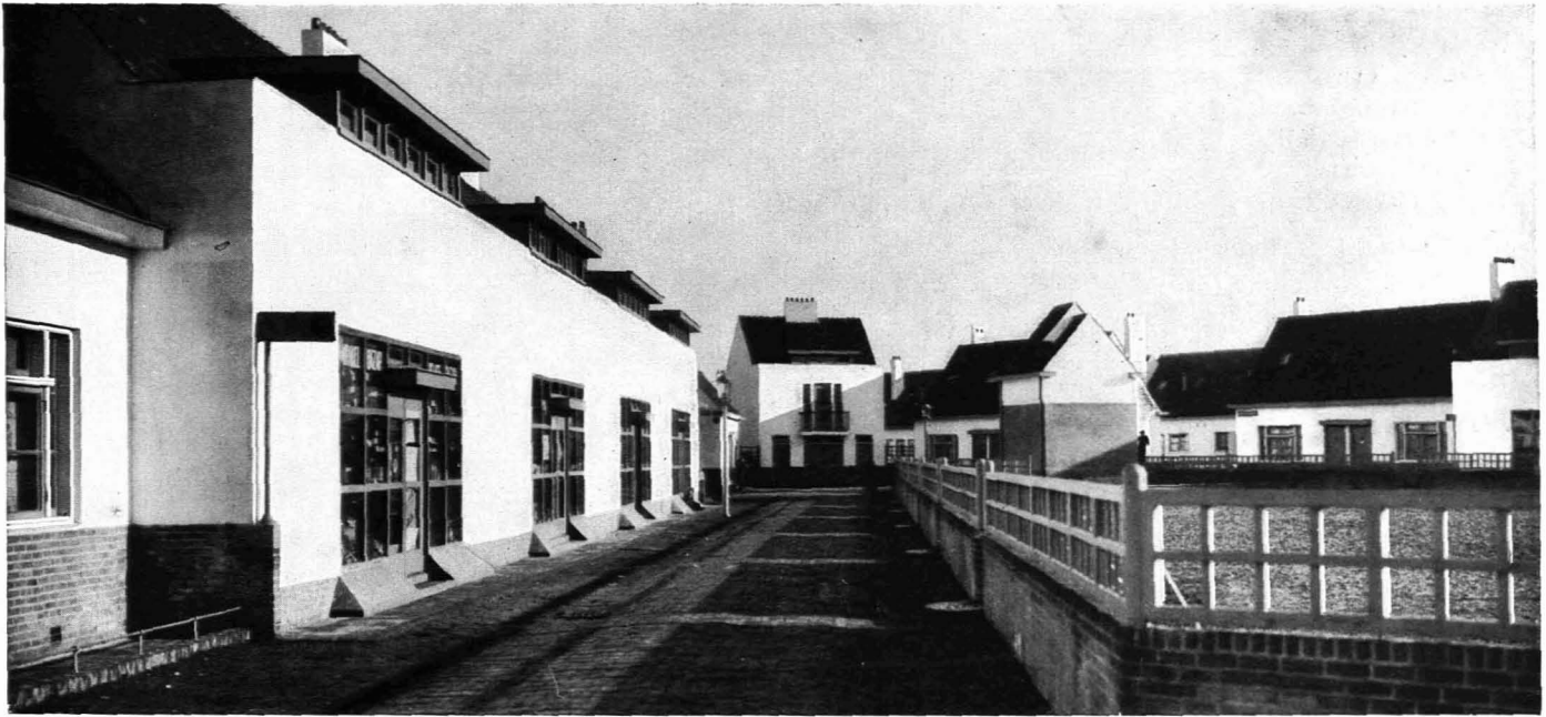
274 / ROTTERDAM „Oud - Mathenesse“. Halbbeständiger Wohnungsbau; links Läden Arch.: J. J. P. Oud
