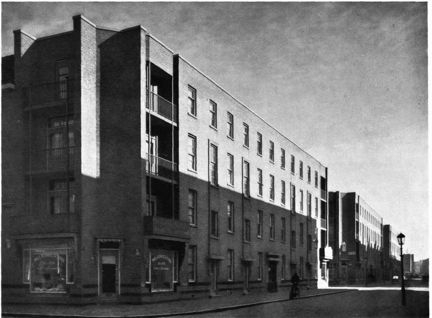
273 / ROTTERDAM "Tusschendyken" Miethäuser, erbaut 1920 Flats, built 1920 Arch.: J. J. P. Oud
