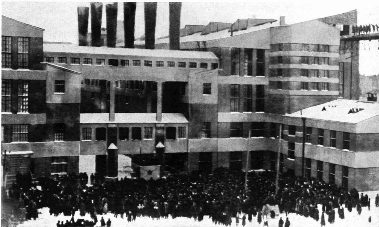
MOSKAU / 266 / MOSCOW Torfkraftwerk Schaturka Power Stations
